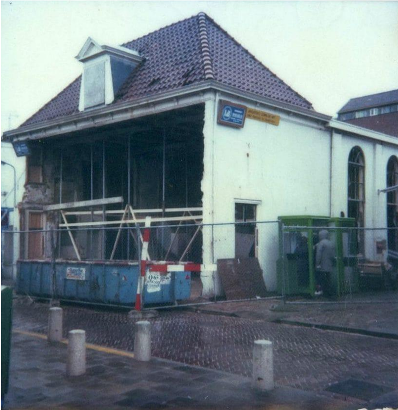
1985. Egmond aan Zee. Sloop voormalig Postkantoor aan de Zuiderstraat. Was als postkantoor in gebruik tussen 1886 en 1983
